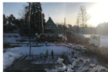
Brf Villa Målarhöjden i byggskede Feb 9, 2021
